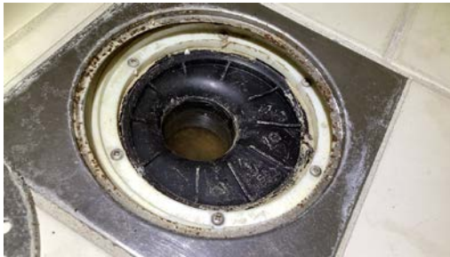
Kontroll av sluk.
