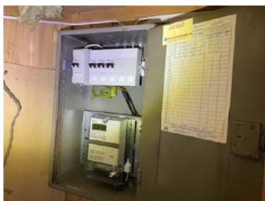
El-anlegg med automatsikringer. I hovedsak åpent ledningsnett. Sikringsskapet er plassert i bod.
