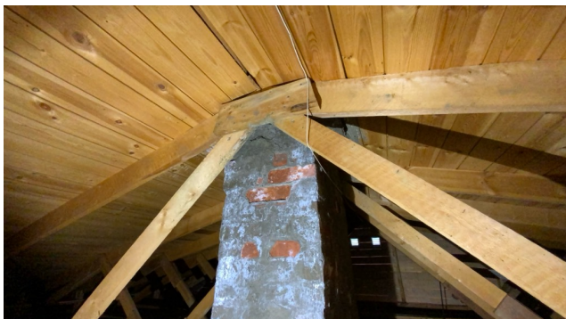
Kontroll rundt pipeløp.
