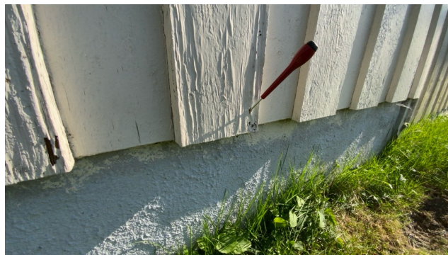
Påviste råteskader.
