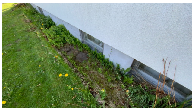
Kontroll av drenering/fuktsikring.
