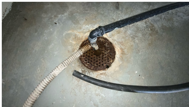
Kontroll av sluk.
