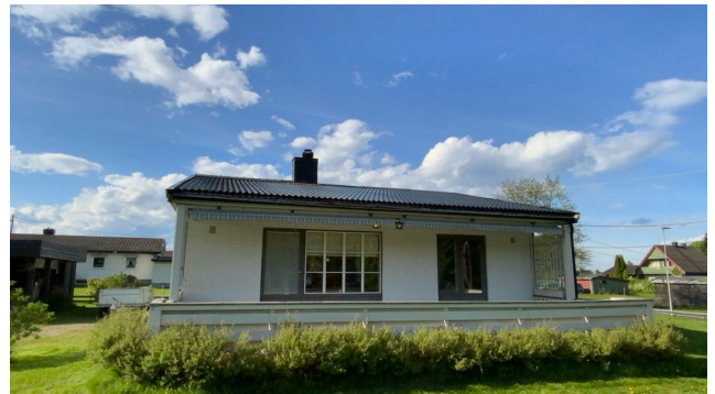
Besiktigelse av taktekke.
