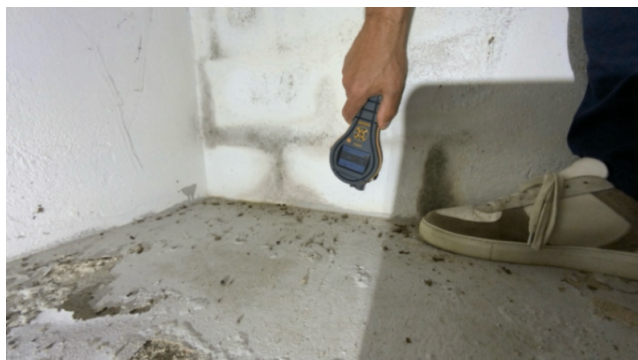
Utført fuktsøk på nedre del av grunnmur.
