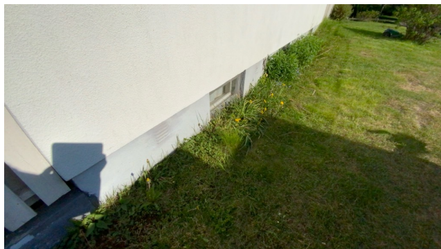
Kontroll av drenering/fuktsikring.
