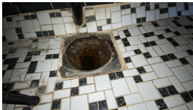
Kontroll av sluk.
