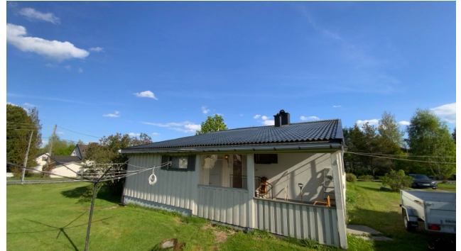
Besiktigelse av taktekke.
