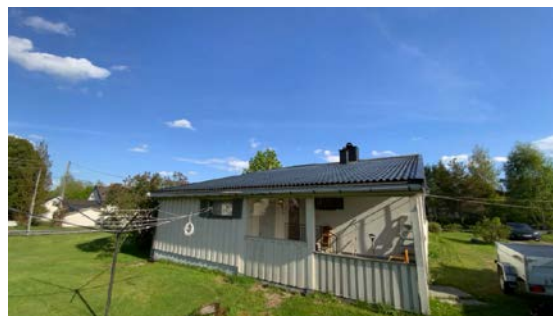
Besiktigelse av taktekke.
