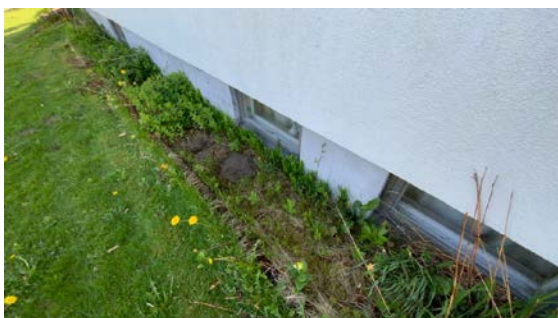
Kontroll av drenering/fuktsikring.
