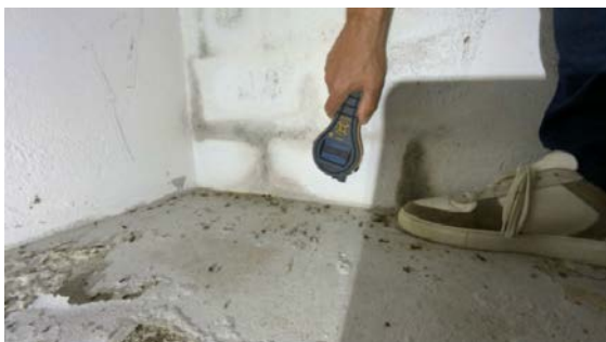
Utført fuktsøk på nedre del av grunnmur.
