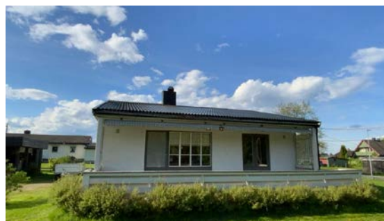
Besiktigelse av taktekke.
