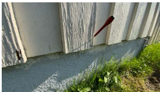
Påviste råteskader.
