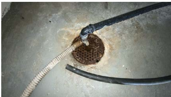
Kontroll av sluk.
