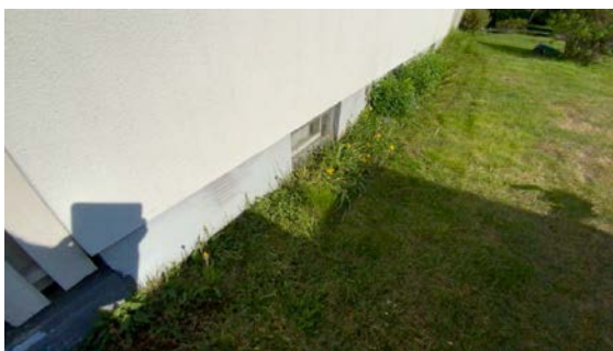
Kontroll av drenering/fuktsikring.
