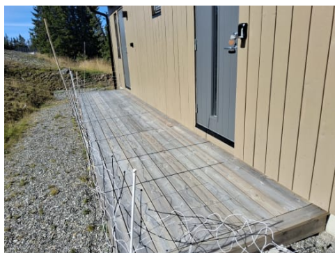
Oversiktsbilde terrasse ved inngangsparti.
