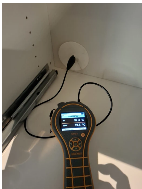
Bilde fra fuktmåling i veggkonstruksjon tilstøtende dusjsone.
