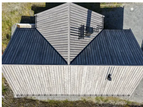
Taket er tekket med trebord.
