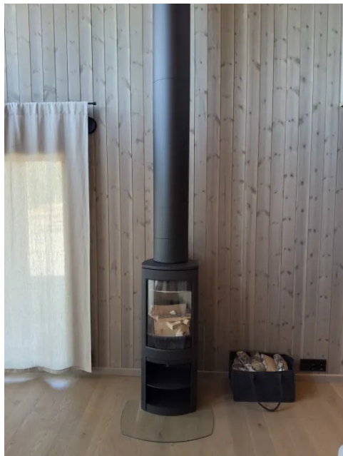
Vedovn med glassdør i stue.
