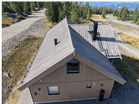
Fritidsboligen er oppført med saltak.
