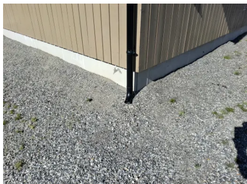
Fritidsboligen er oppført med støpt plate på mark.
