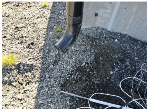
Takrennedløp med utkast.
