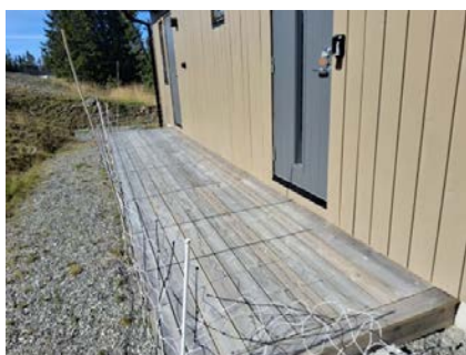
Oversiktsbilde terrasse ved inngangsparti.
