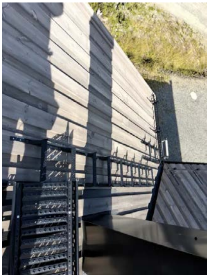
Det er etablert snøfanger og takstige på taket.
