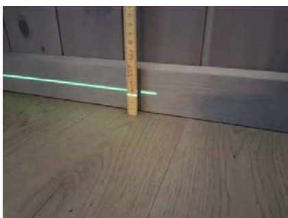
Etasjeskiller er kontrollert med nivelleringslaser.
