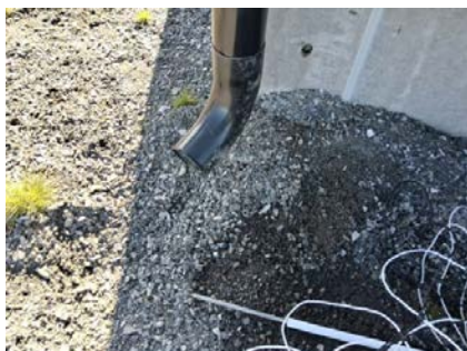
Takrennenedløp med utkast.
