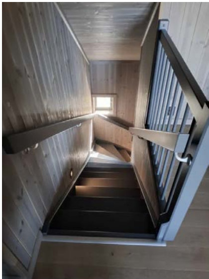
Lukket trapp mellom etasjene.
