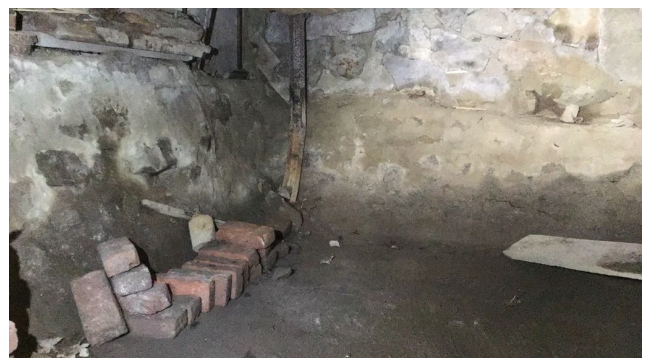
Eldre potetkjeller under boligen
