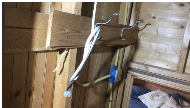
Løst ledning på kott
