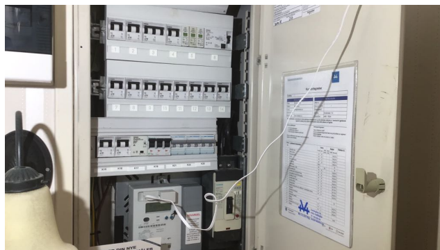
Løst ledning på kott
