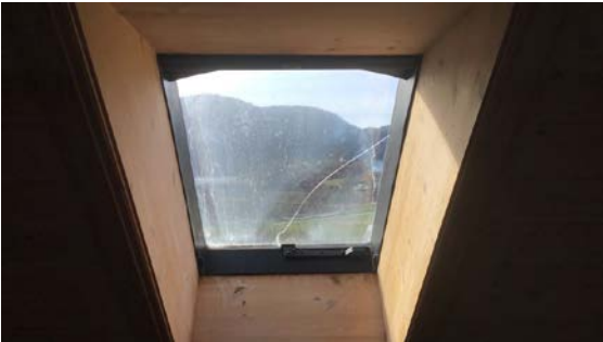
Takvindu med sprekt glass
