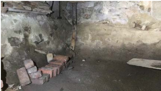
Eldre potetkjeller under boligen
