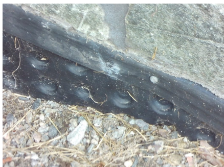
Synlig fuktsikring inntil grunnmur
