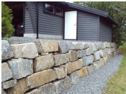
Deler av forstøtningsmur.
