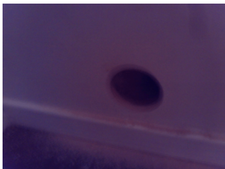
Hulltaking i utford vegg på garderoberom.
