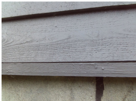
Lite tilgang på luft bak kledningen mot grunnmur som er skiferbelagt.
