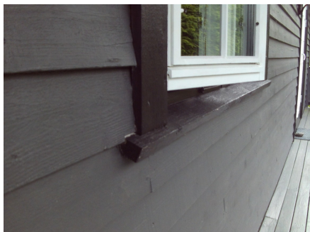
Deler av kledningen med tilhørende belistninger.
