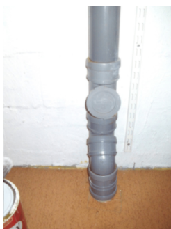
Avløpsrør av plast med stakeluke
