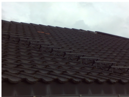
Deler av taktekkingen
