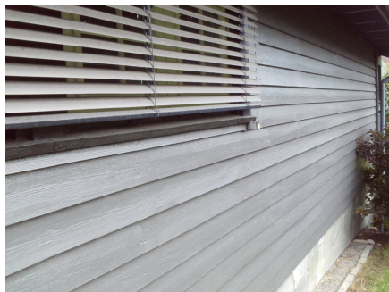
Deler av ene fasaden.
