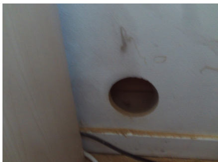
Hulltaking fra soverommet.
