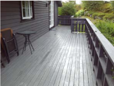
Deler av terrasse på baksiden av boligen
