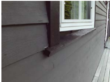
Deler av kledningen med tilhørende belistninger.
