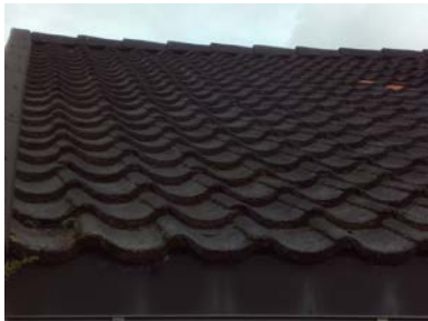
Har fått en del slitasje på selve taksteinen.
