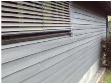
Deler av ene fasaden.
