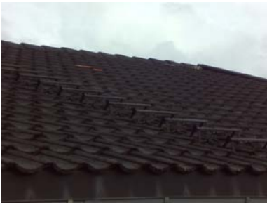
Deler av taktekkingen
