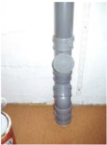
Avløpsrør av plast med stakeluke
