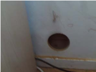
Hulltaking fra soverommet.
