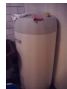
Nyere bereder er plassert på vaskerommet
