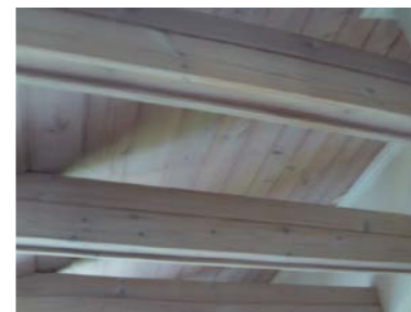
Takkonstruksjonen er en lukket konstruksjon.
