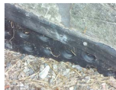
Synlig fuksikring inntil grunnmur
