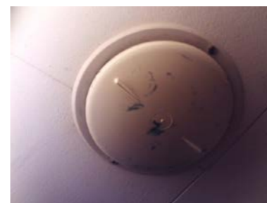
Naturlig ventilasjon av rommet
