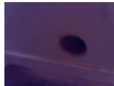
Hulltaking i utford vegg på garderoberom.
