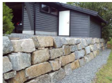
Deler av forstøtningsmur.
