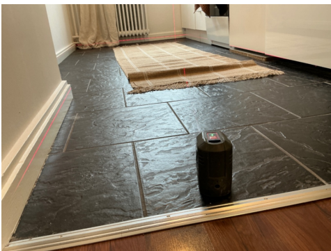
Nivellering kjøkken, ingen avvik registrert
