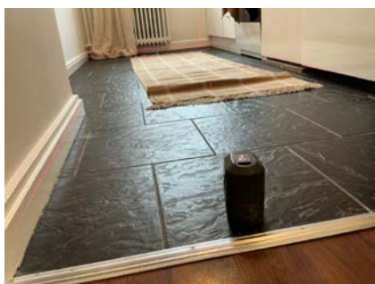
Nivellering kjøkken, ingen avvik registrert
