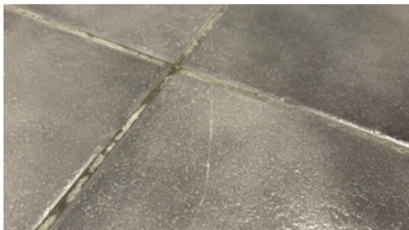
Sprekker på en flis
