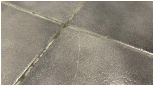
Sprekker på en flis
