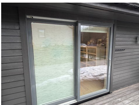
Alu kledd utvendig
