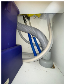
Røropplegg under kjøkkenbenk.
