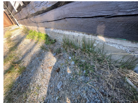
Sett fra utside østvegg
