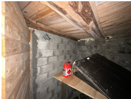
Sett fra inside kjellerrom under veranda
