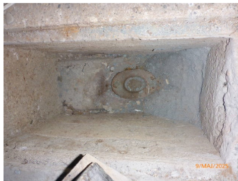
Stakepunkt i kjeller
