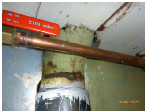
Avløpsrør fra under vaskerommet
