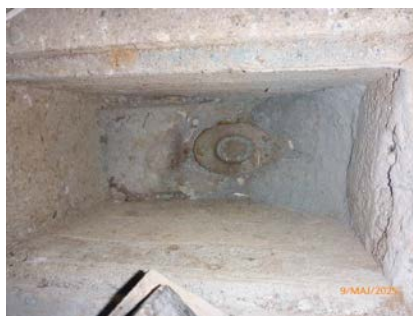
Stakepunkt i kjeller
