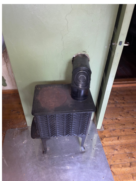
Eksempel på pipe tildekket med trepanel.
