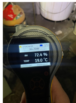
Det måles høy luftfuktighet i kjellerrom.
