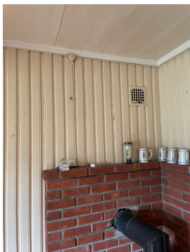
Eksempel på pipe tildekket med trepanel.
