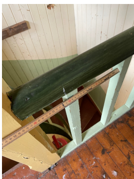
Åpninger over 10 cm jmf. dagens regelverk.
