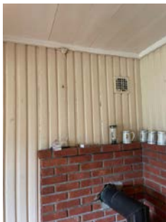
Eksempel på pipe tildekket med trepanel.
