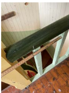
Åpninger over 10 cm jmf. dagens regelverk.
