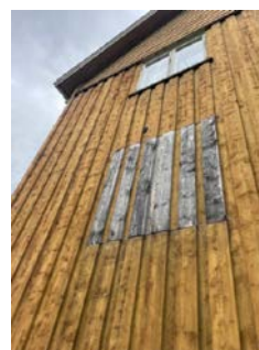
Ufaglig lukking av gamle vindusåpninger og værslitte/oppsprukkede overflater
