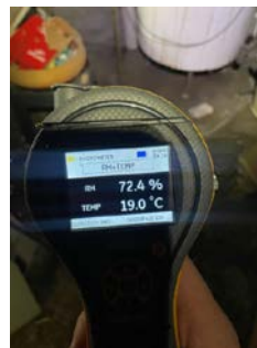
Det måles høy luftfuktighet i kjellerrom.
