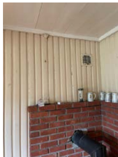
Eksempel på pipe tildekket med trepanel.
