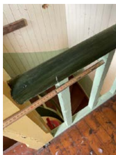
Åpninger over 10 cm jmf. dagens regelverk.
