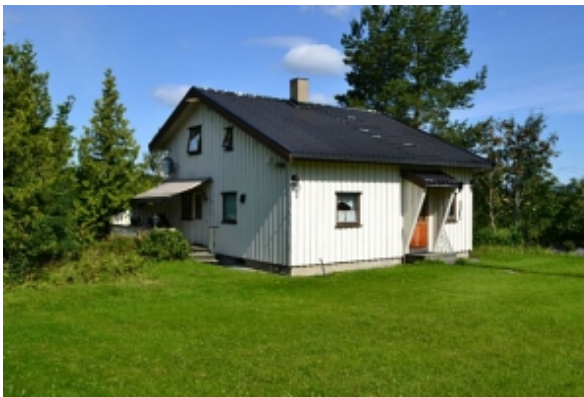
Hennisandveien 11 Sidebygning. Inngang mot øst.
