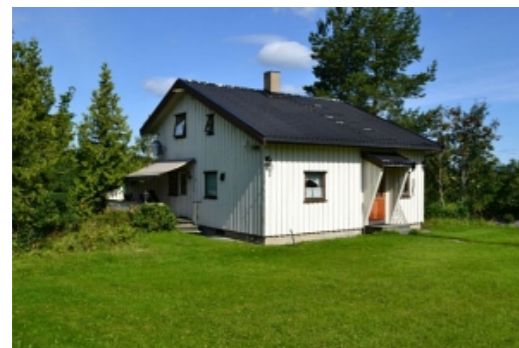
Hennisandveien 11 Sidebygning. Inngang mot øst.
