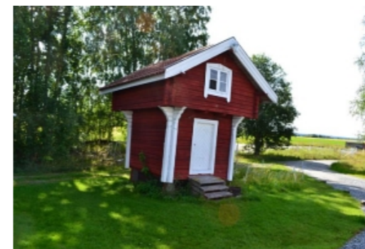
Stabbur Inngang på vestvegg
