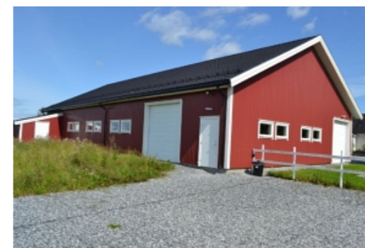
Driftsbygning Syd og øst vegg
