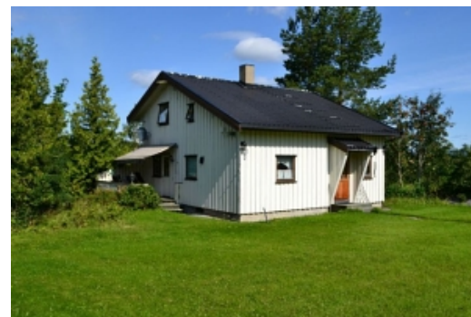
Hennisandveien 11 Sidebygning. Inngang mot øst.
