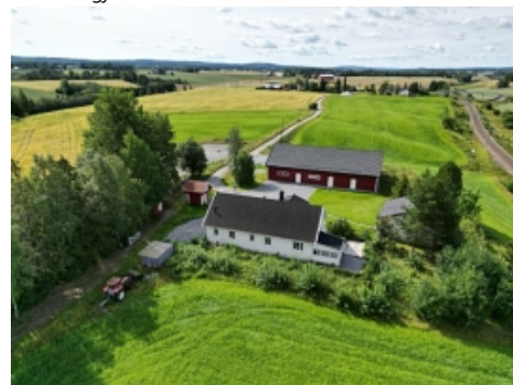
Hennisandvei 9 Fasade mot nord.
