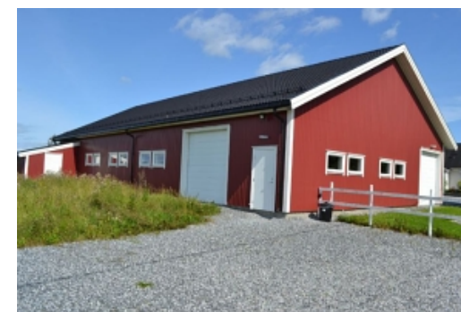
Driftsbygning Syd og øst vegg
