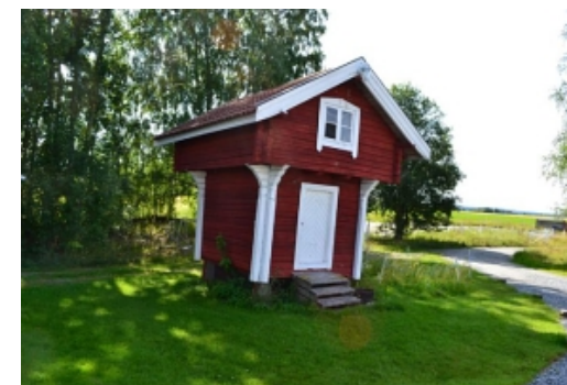
Stabbur Inngang på vestvegg
