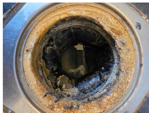
Membran i sluk kan ikke konstateres
