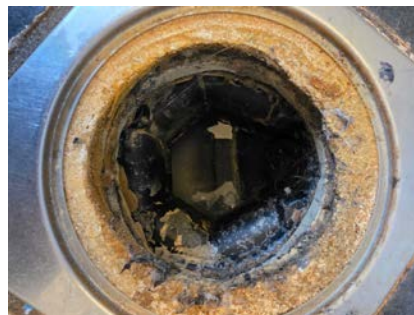
Membran i sluk kan ikke konstateres
