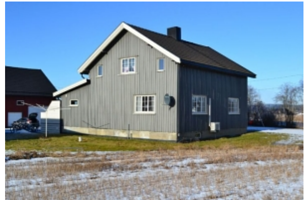
Falletveien 14 Fasade mot syd og øst
