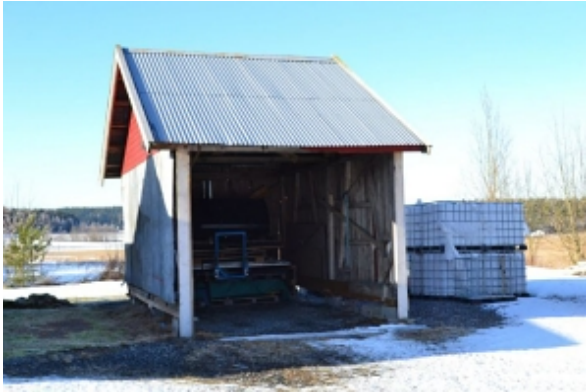
Garasje/vedskjul Front mot øst.
