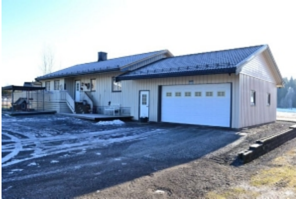
Falletveien 14 Fasade mot tunet.
