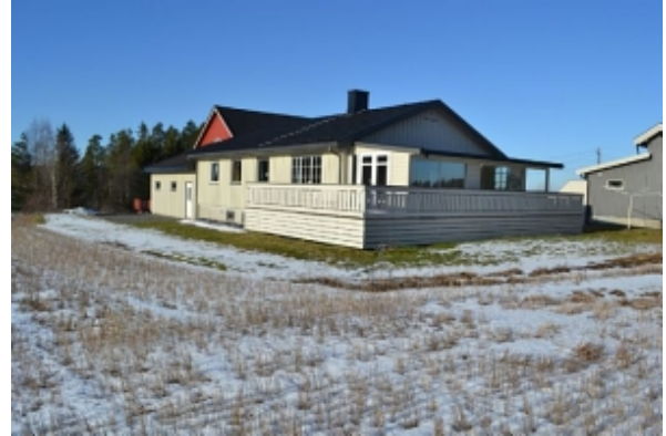
Falletveien 14 Fasade mot syd og øst.
