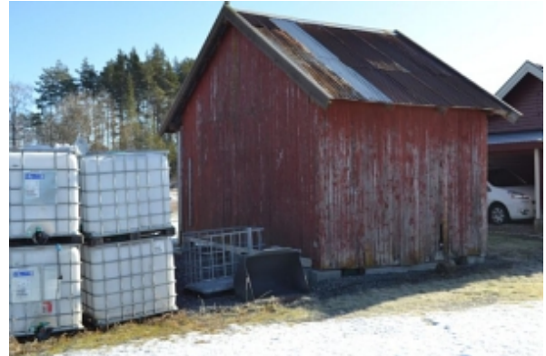
Garasje/vedskjul Nord og vest vegg.
