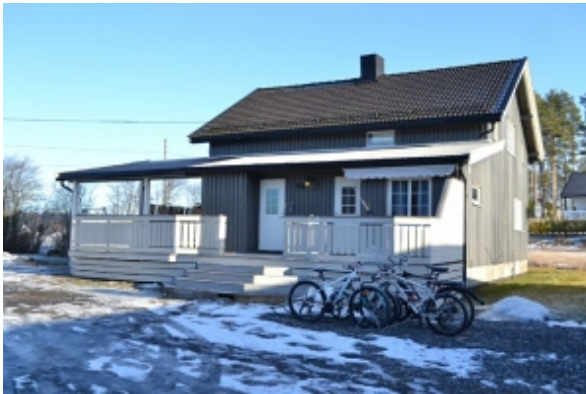
Falletveien 12 Fasade mot tunet og vest.
