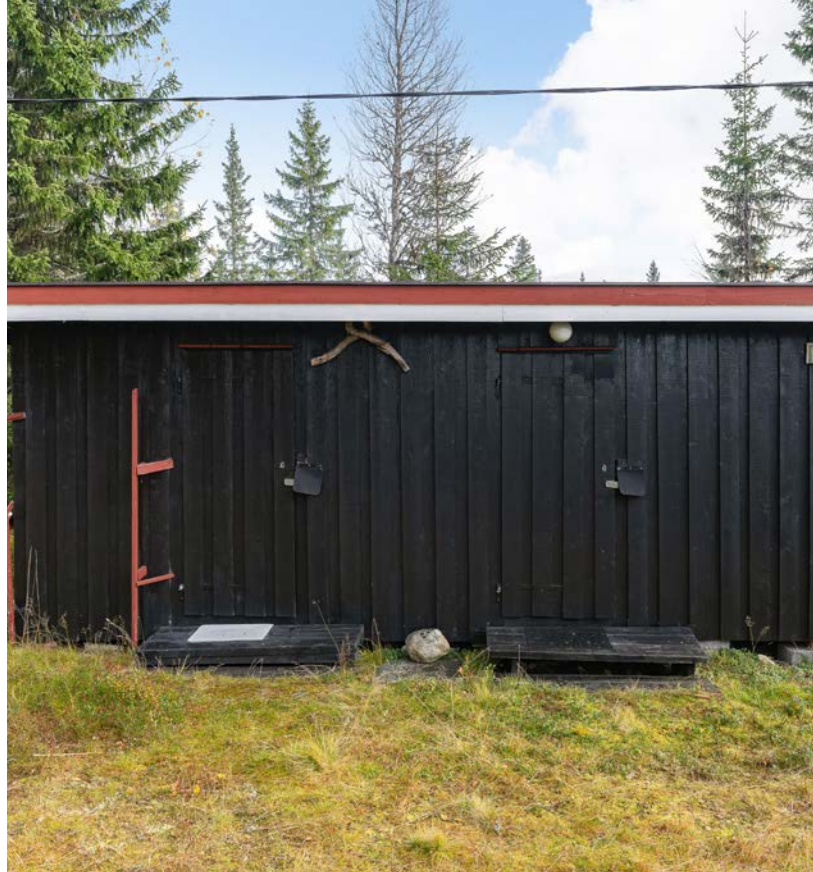
Frittstående annekset fra rundt 1995 med utedo, lagringsboder og rom innredet som soverom.
