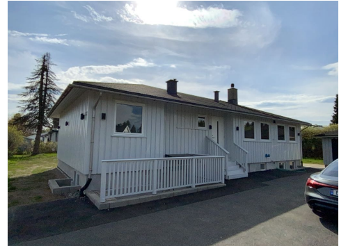
Besiktigelse av taktekke.
