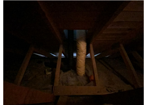
Kontroll rundt rørgjennomføringer.
