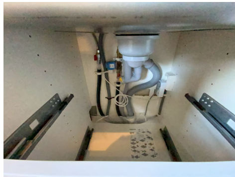
Besiktigelse av røropplegg.
