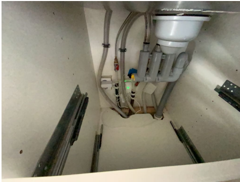
Besiktigelse av røropplegg.
