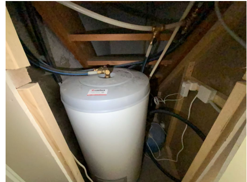
Besiktigelse av bereder.
