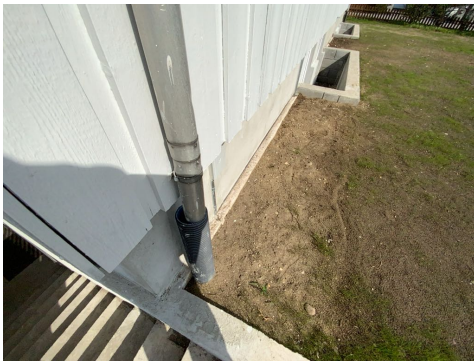
Kontroll av drenering/fuktsikring.
