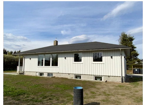
Besiktigelse av taktekke.
