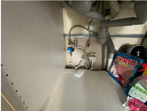
Besiktigelse av røropplegg.
