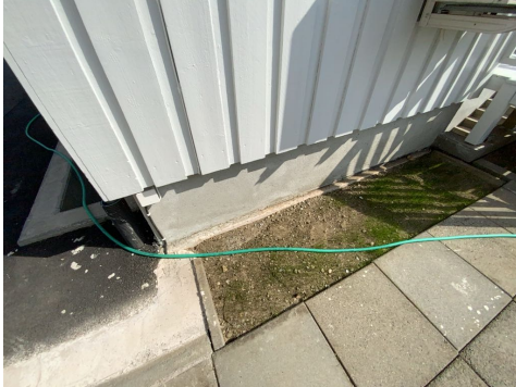
Kontroll av drenering/fuktsikring.
