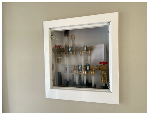
Besiktigelse av røropplegg.
