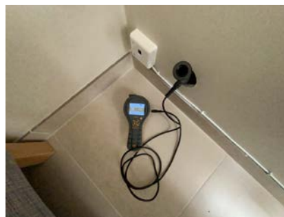
Utført hulltaking på rom under terreng.
