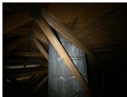
Kontroll rundt pipeløp.
