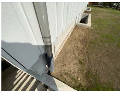
Kontroll av drenering/fuktsikring.
