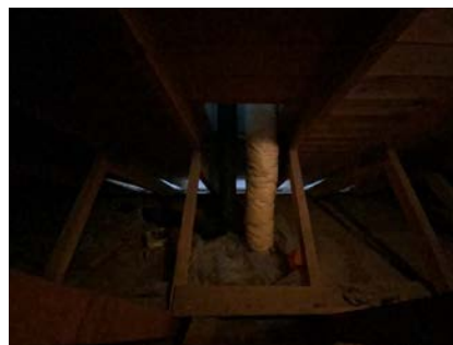
Kontroll rundt rørgjennomføringer.
