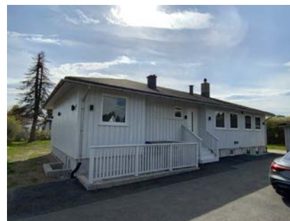
Besiktigelse av taktekke.
