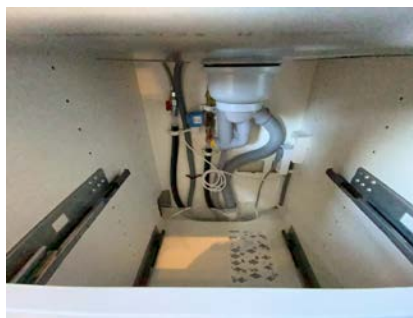
Besiktigelse av røropplegg.
