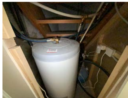
Besiktigelse av bereder.
