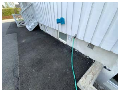
Kontroll av drenering/fuktsikring.
