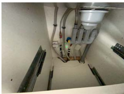
Besiktigelse av røropplegg.
