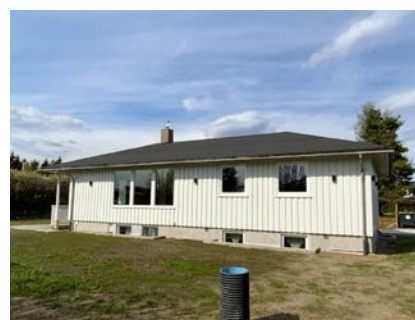
Besiktigelse av taktekke.
