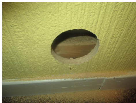
Hulltaking i fra soverom.
