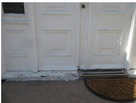
Eldre tofløyet ytterdør
