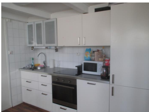
Deler av innredningen med en mindre skade på ene fronten.
