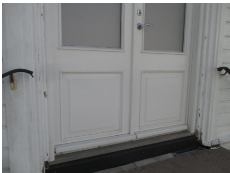
Nyere ytterdør til ene forretningslokale.
