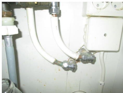
Kobberrør med plastkappe.
