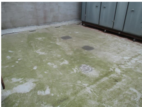
Glassfiberdekke/tekkning.
