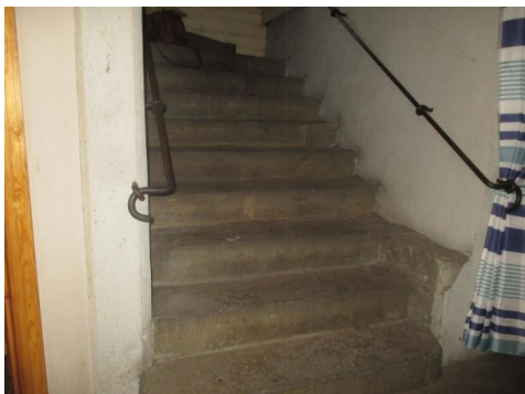
Støpt trapp til kjeller.
