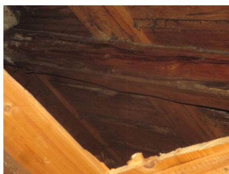
Deler av øverste loftet er synlig i rundt pipe.
