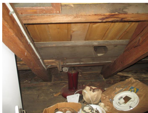
Noe bord på undertaket er blitt skiftet ut.
