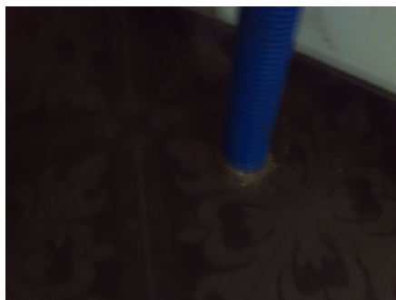
Usikker rørgjennomføring i gulvet
