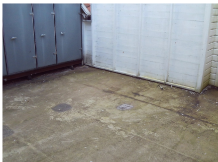
Slitt tekking av glassfiber.
