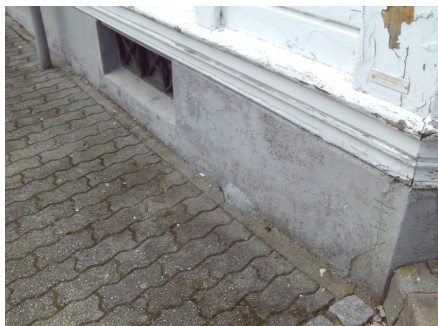
Deler av grunnmur.
