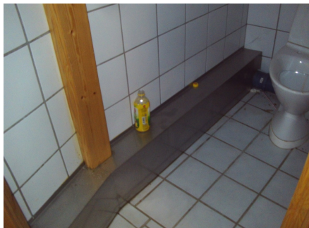
Deler av ene toalettrom i kjeller
