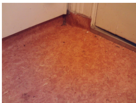
Eldre gulvbelegg med oppkant
