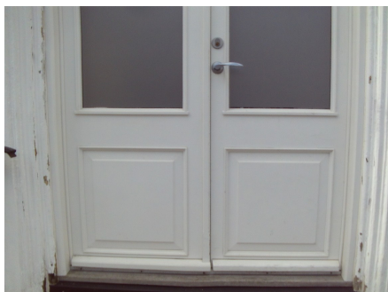
Nyere tofløyet ytterdør.
