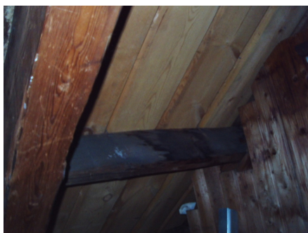
Noe av undertaket er byttet.
