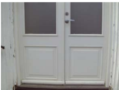
Nyere tofløyet ytterdør.
