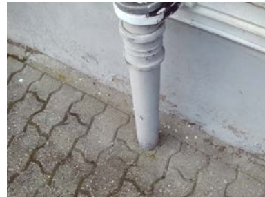
Takvann er ledet bort i fra grunnmur.
