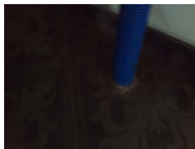
Usikker rørgjennomføring i gulvet
