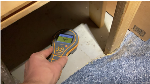
Ved enkle fuktsøk ble det ikke registrert unormale verdier ved befarng.
