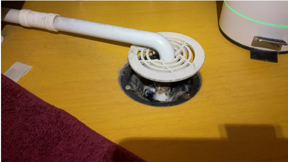
Kontroll av sluk.
