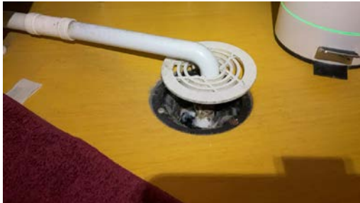
Kontroll av sluk.
