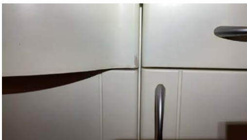
Sår/hakk på innredning.
