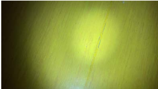
Membran har sprekk, våtrommet er utett.
