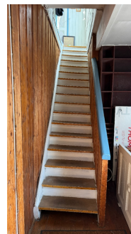
Tretrapp mellom 1.etasje og 2.etasje
