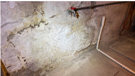
Synlig saltutslag på grunnmurspuss
