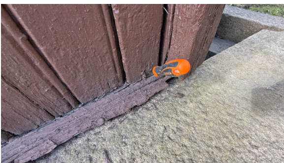
Trekonstruksjon ført helt ned til betongplate
