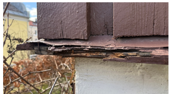
Råteskadet vannbrett
