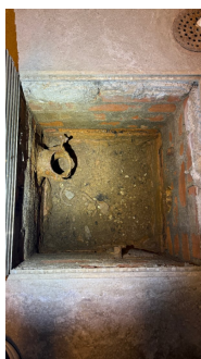
Synlig saltutslag på grunnmurspuss
