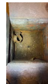
Synlig saltutslag på grunnmurspuss
