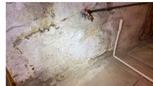
Synlig saltutslag på grunnmurspuss
