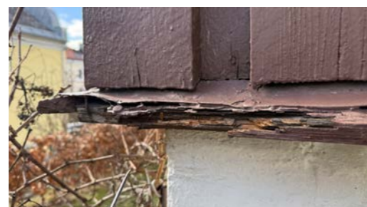
Råteskadet vannbrett
