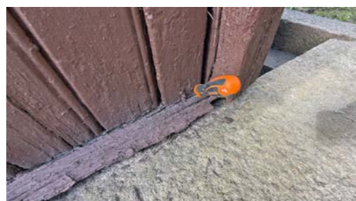
Trekonstruksjon ført helt ned til betongplate
