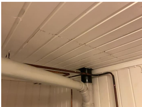
Utbedret lekkasje i tak fra bad.
