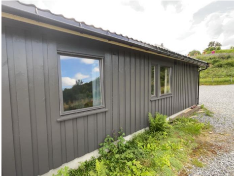
Vindu på soverom
