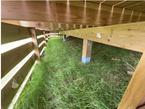
Det er benyttet stolpespyd som fundamentering til veranda
