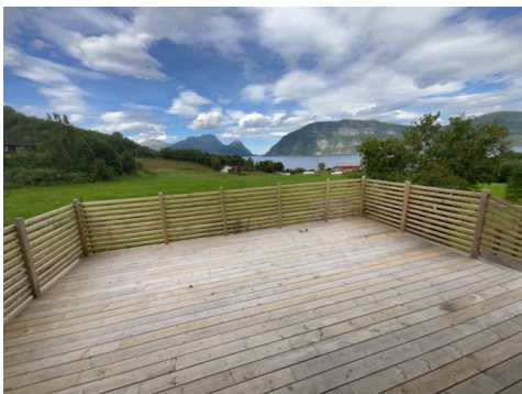
Veranda med utgang fra stue
