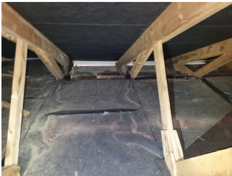
Synlig lufting ut mot raftekasse
