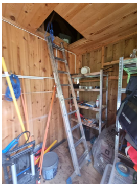
Tilgang til loft via luke i himling på tilbygget utebod
