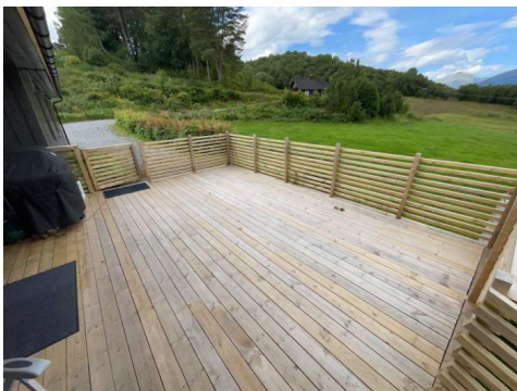
Veranda med utgang fra stue
