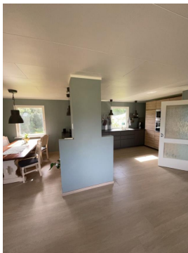
Pipe er innkledd med plater og synlig på kjøkken/stue
