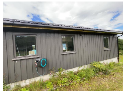
Vindu på vaskerom og kjøkken/stue
