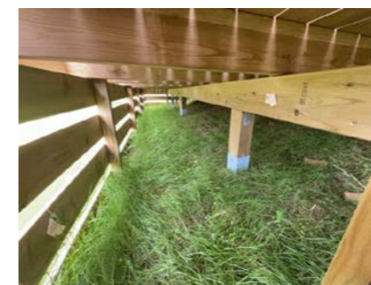
Det er benyttet stolpespyd som fundamentering til veranda
