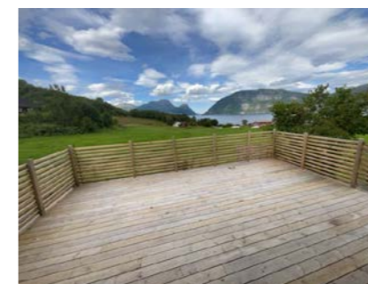
Veranda med utgang fra stue
