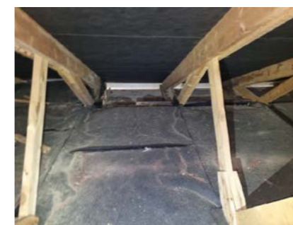
Synlig lufting ut mot raftekasse
