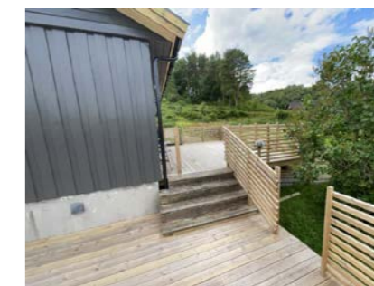
Trapp mellom nivå på veranda. Det er anbefalt med håndløper på begge sider.
