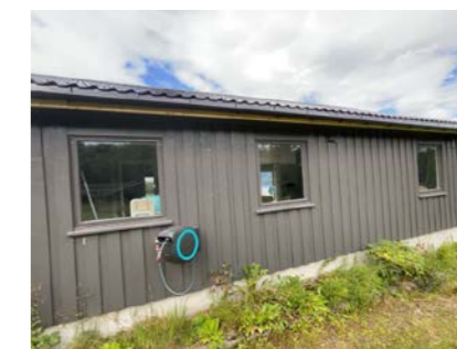
Vindu på vaskerom og kjøkken/stue
