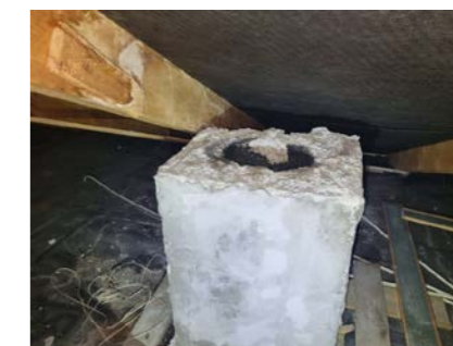
Rest av pipe som er synlig på kryploft
