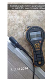
Kontroll av gulv mellom gang og vaskerom. Det er målt 7,8 %, ingen forhøyde fuktavvik
