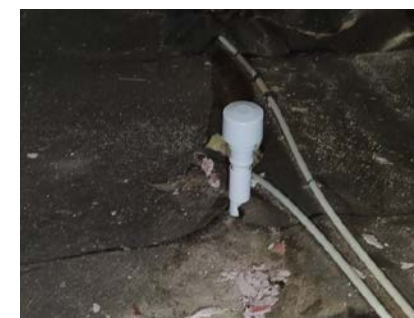
Lufteventil avløp er plassert på kryploft
