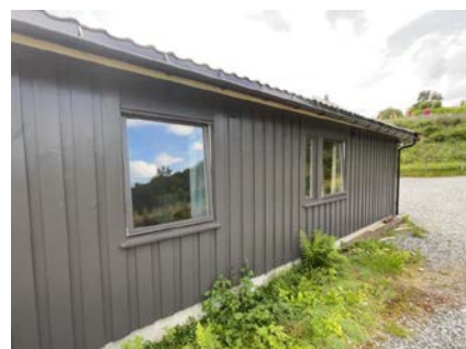
Vindu på soverom
