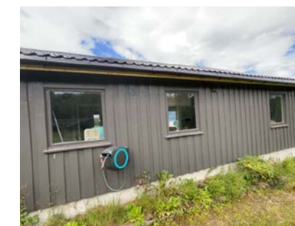
Vindu på vaskerom og kjøkken/stue
