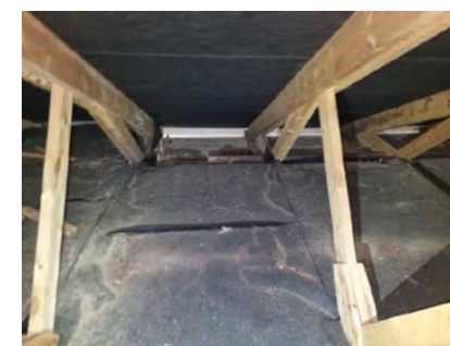
Synlig lufting ut mot raftekasse
