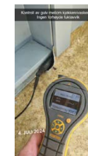
Kontroll av gulv mellom vaskerom og kjøkken. Ingen fuktavvik
