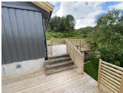
Trapp mellom nivå på veranda. Det er anbefalt med håndløper på begge sider.
