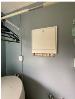
Rørfordelingsskap er felt inn i eldre vegg på vaskerom.
