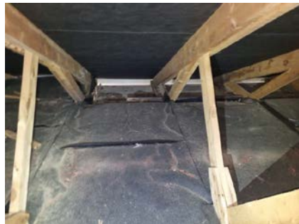
Synlig lufting ut mot raftekasse
