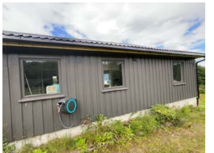
Vindu på vaskerom og kjøkken/stue
