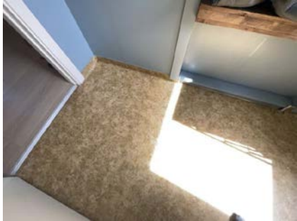
Åpning i belegg mot kjøkken og mot gang
