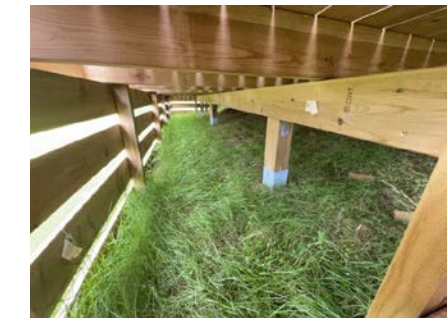
Det er benyttet stolpespyd som fundamentering til veranda
