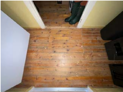
Luke til krypkjeller er tilgjengelig i bod
