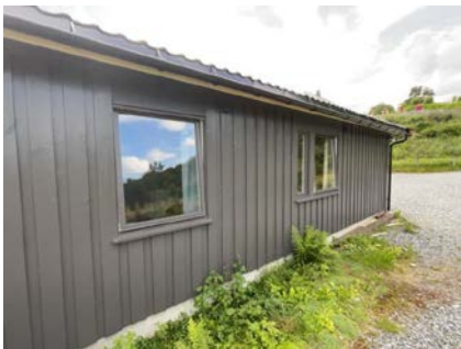
Vindu på soverom
