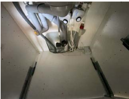
Vannstoppventiler med følere på varmt og kaldt vann under vask på kjøkken.
