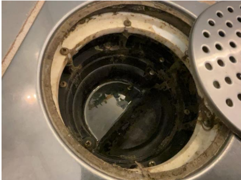
1. ETASJE > BAD/TOALETROM I 1. ETASJE
