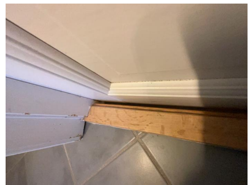
1. ETASJE > BAD/TOALETROM I 1. ETASJE
