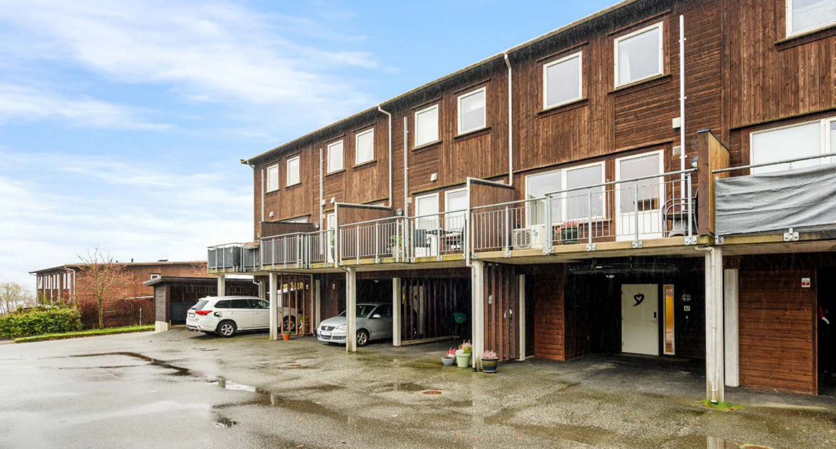
Parkering i carport med opplegg for elbil.
