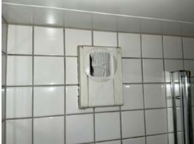
Kontroll av avtrekk.
