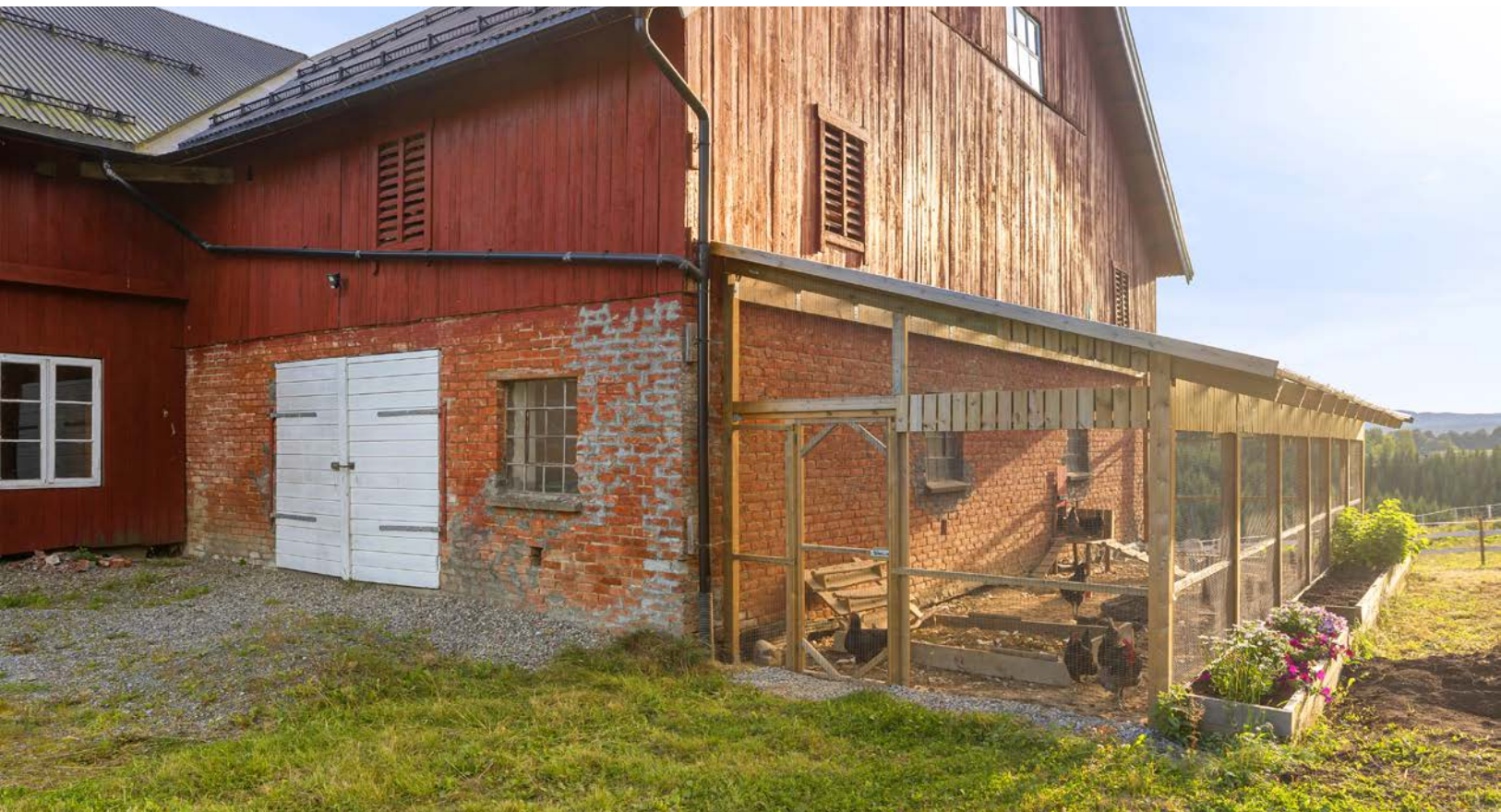
Låven er bygget i tradisjonell stil. Det er etablert hønsegård på siden av bygget.
