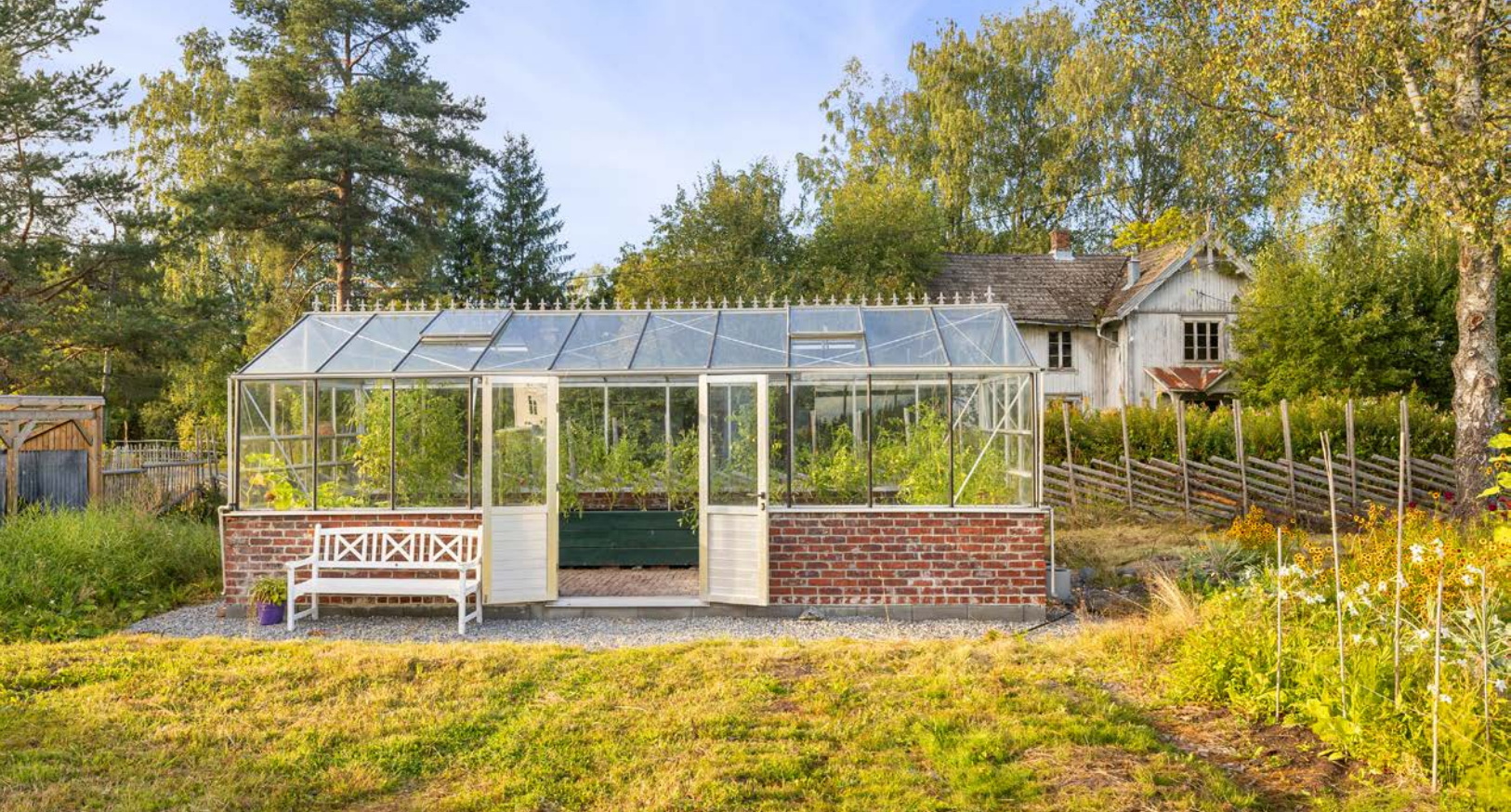
Drivhuset ble oppført i 2021, og har betongfundament og glassvegger.
