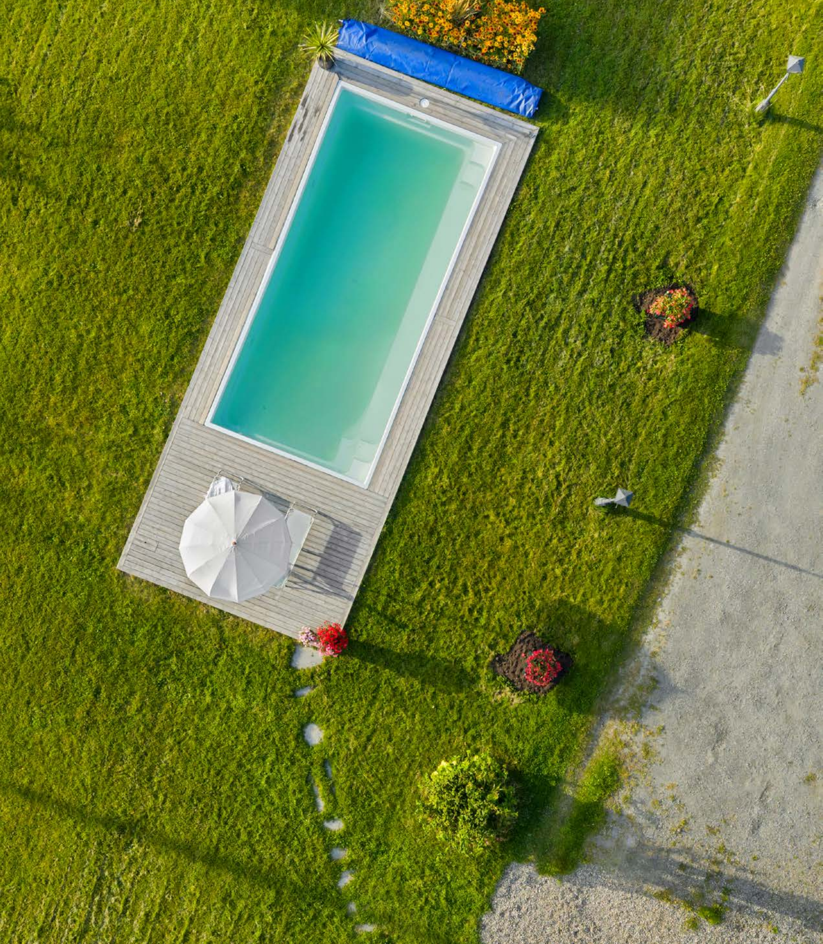
Svømmebassenget er et glassfiberbasseng med oppvarming via luft til vann varmpumpe.
