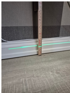
Målt fra 4,4 cm mot yttervegg...
