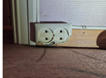
Skadet stikkontakt.
